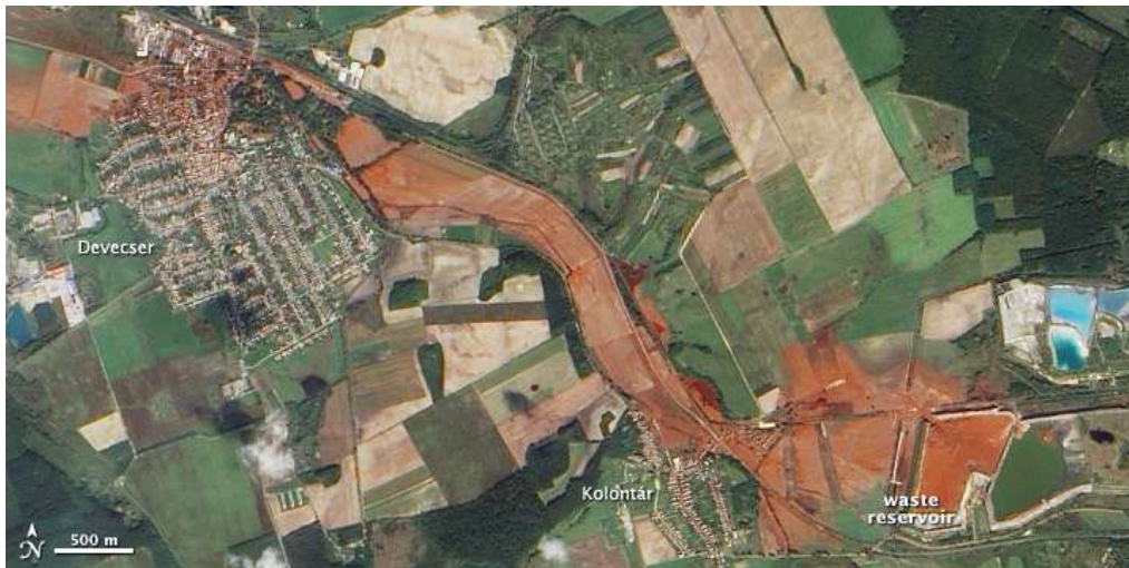
Figure 2.18 : zones inondées par la rupture du bassin de décantation de l'usine d'Ajka en Hongrie. Photographie satellitaire prise le 9 octobre 2010. Source : NASA .
