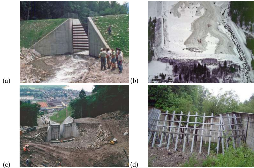
Figure 3.6 : (a) plage de dépôt du torrent de Saint-Clément à Tours-en-Savoie (Savoie); (b) dispositif paravalanche de Taconnaz entre les Houches et Chamonix-Mont-Blanc (Haute-Savoie); (c) construction du barrage de rétention sur le torrent du Pissot (Vaud) au-dessus de Villeneuve après la crue de 1995; (d) barrage-grille format un « dépotoir » à sédiment à Sachseln (Obwald) cliché Andreas Götz (OFEG).
