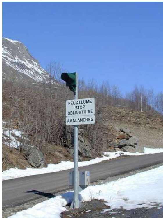
Figure 3.13 : le feu de signalisation d'un détecteur routier d'avalanche (ici sur la route départementale menant à Clavans, Isère).
