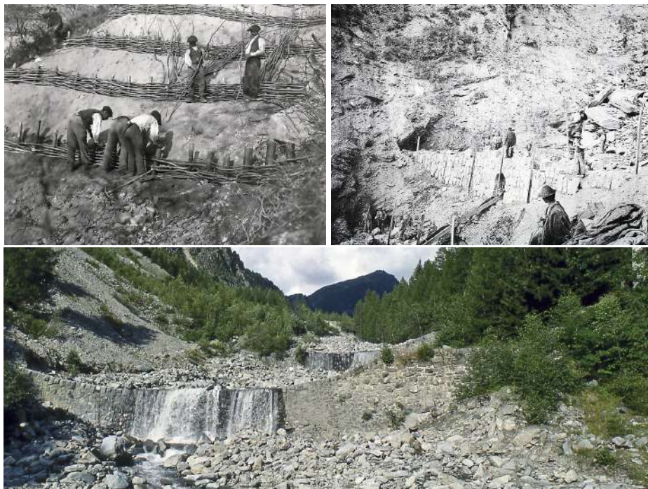
Figure 1.13 : en haut à gauche, travaux de clayonnage sur des berges ; en haut à droite, construction d'un barrage sur le Nant Trouble (Savoie) en 1890. En bas, seuils construits par le service RTM à la fin du XIX e siècle sur le Nant Saint-Claude (Savoie). Les deux photographies d'archive sont tirées du livre de Jeudy (2006) .
