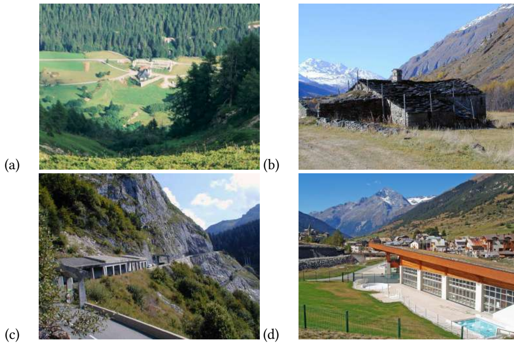
Figure 3.7 : (a) étrave devant l'église de Vallorcine (Haute-Savoie) construite au début du xviii e siècle pour protéger l'église et le presbytère; (b) étrave accolée au bâtiment à protéger (Bessans, Savoie); (c) galerie protégeant la route de Mieussy (Haute-Savoie) contre les avalanches et les chutes de blocs; (d) à Lanslevillard (Savoie), la piscine est protégée des avalanches par sa toiture.
