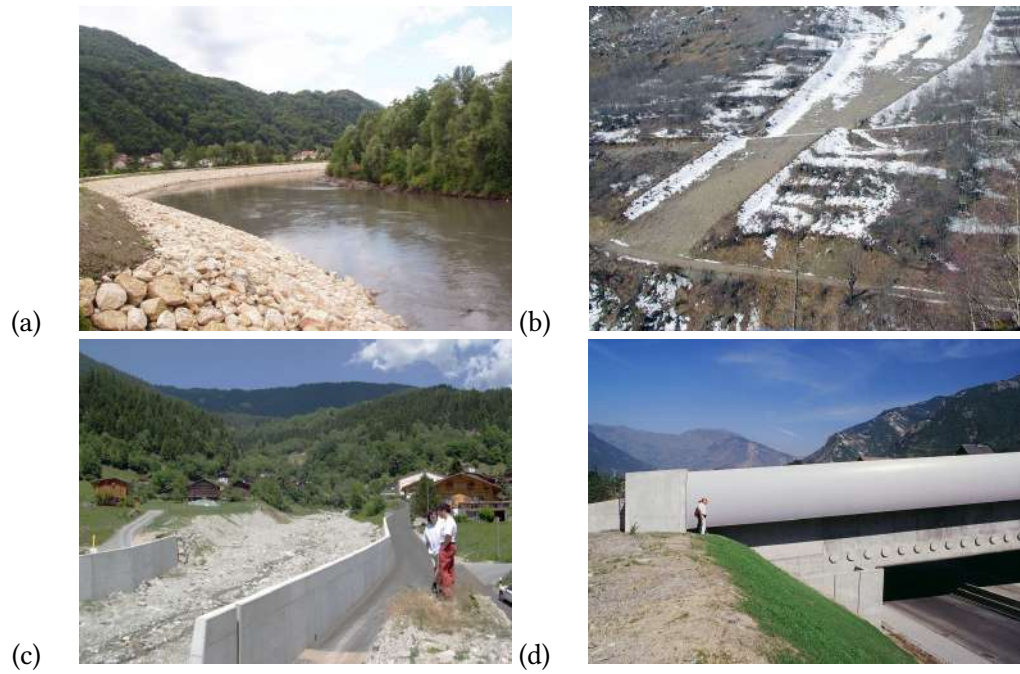
Figure 3.11 : (a) digue de l'Isère (ici, vers Grenoble); (b) digue de contention de la route de Clavans (Isère); (c) digue de contention à Schlans (Grisons); (d) digue de contention et viaduc du torrent du Saint-Bernard (Savoie) enjambant l'autoroute de la Maurienne.
