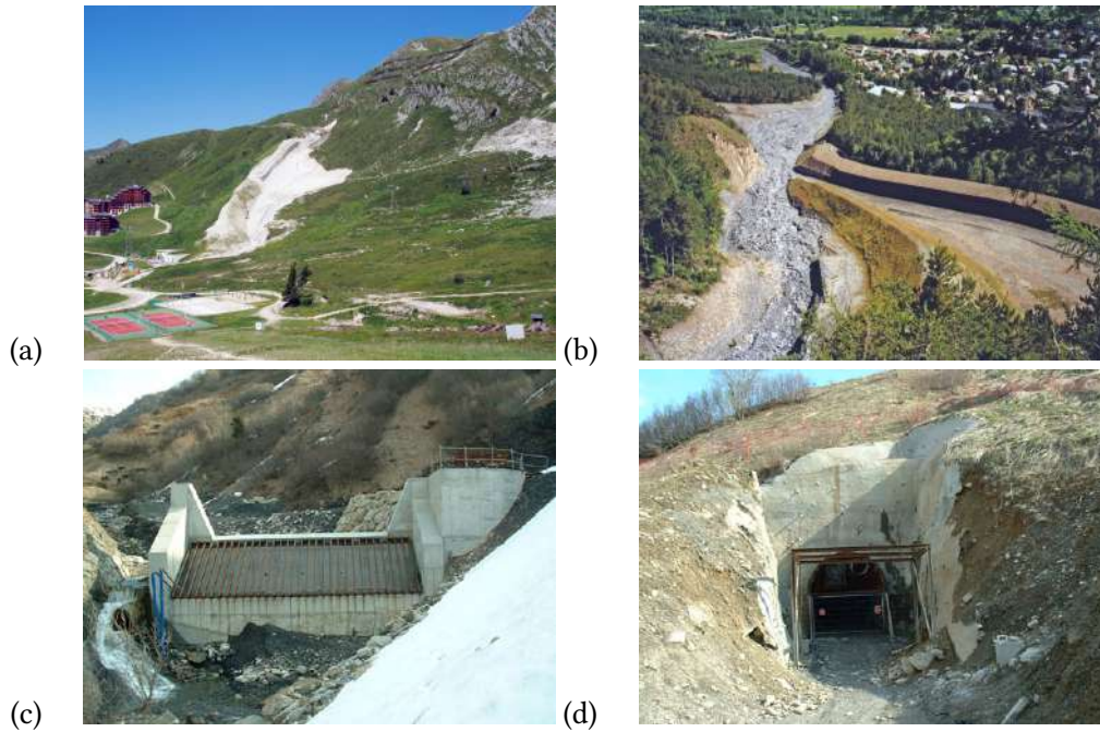
Figure 3.8 : (a) tourne de Belle-Plagne (Savoie) après sa rénovation en 2002 ; les avalanches partent de la zone équipée de râteliers, située plus haut. (b) tourne du Saint-Antoine à Bourg-d'Oisans (Isère) ; la tourne sert à dévier des laves torrentielles (issues des clappiers sous les falaises dominant le torrent du Saint-Antoine) des zones urbanisées du Bourg-d'Oisans, en particulier un collège. (c, d) dérivation de l'Arve au niveau du glissement des Posettes au-dessus du Tour (commune de Chamonix-Mont-Blanc, Haute-Savoie) : quasiment à sa source, l'Arve traversait le pied du mouvement de terrain des Posettes, sapait le versant, et entraînait de grandes quantités de matériaux fins. Pour empêcher ce processus, le maître d'ouvrage a opté pour une solution originale : le torrent est dévié de son lit en empruntant un syphon (cliché c), puis en suivant une galerie qui conduit les eaux plusieurs centaines de mètres plus en aval.
