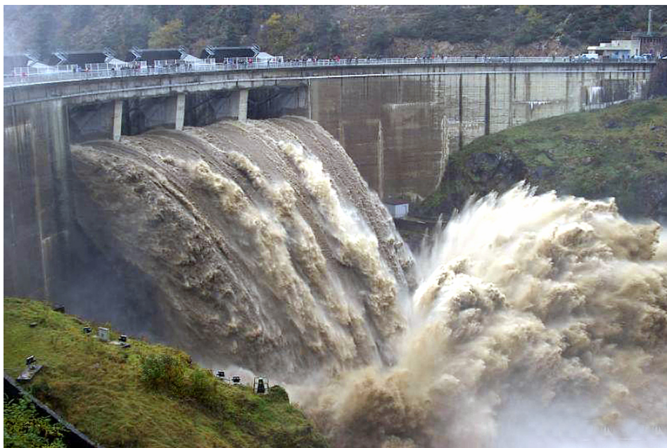
Figure 5.46 – Crue de la Loire de novembre 2008 et passage de la crue au niveau de l'évacuateur de crue du barrage de Grangent. Source : DIREN.
