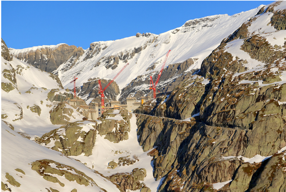
Figure 8 – Travaux d'élévation du barrage du Vieux-Émosson (Finhaut, VS) en 2010. En surélevant de 20 mètres, les ingénieurs ont pu doubler la capacité de la retenue d'eau et la porter à 25 millions de m 3 . Le barrage est relié à la centrale du Nant de Drance, qui permet de turbiner (pour répondre à une demande d'énergie) ou de pomper (lorsque le prix de l'électricité est bas et qu'il y a plus d'offres que de demandes) l'eau entre les lacs d'Émosson et du Vieux-Émosson. La puissance maximale est de 900 MW.
