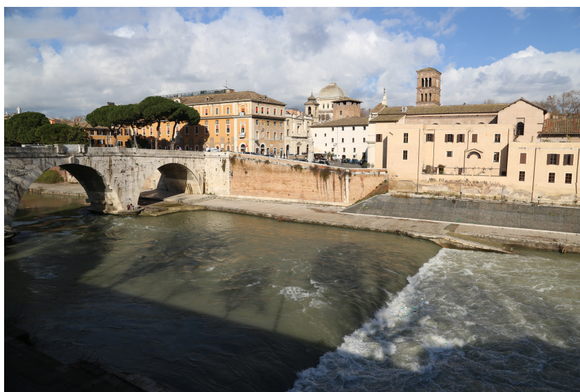
Figure 5.63 – Seuil dénoyé sur le Tibre au niveau de l'île Tibérine à Rome. L'apparition d'eau blanche trahit la formation d'un petit ressaut à l'aval du seuil.
