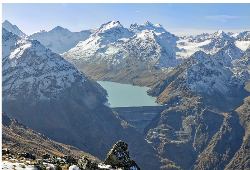
Figure 7 – Barrage-poids de la Grande Dixence. C'est le plus grand ouvrage de sa catégorie à travers le monde. Sa production annuelle est voisine de 2 TWh, soit 3 % de la production électrique suisse (sa puissance maximale est de 2 GW répartie sur les quatre centrales de Bieudron, Fionnay, Chandoline et La Nendaz).
