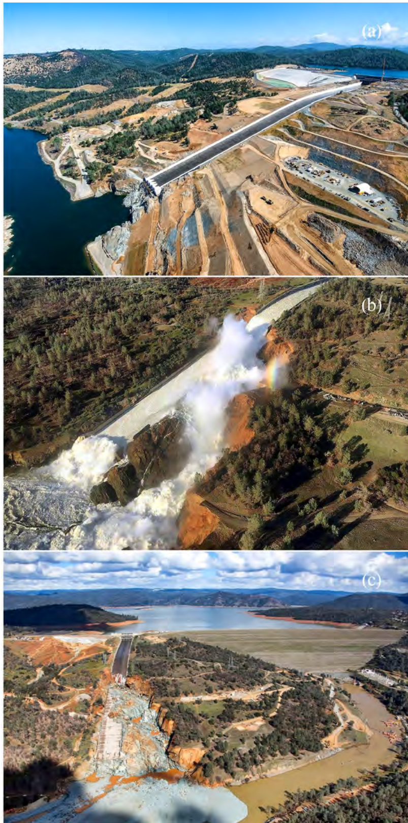
Figure 3.6 – Évacuateur de crue du barrage d’Oroville (Californie). (a) Vue d’ensemble avant l’accident. (b) Évacuateur de crue en bon état de fonctionnement lors de la crue de juillet 2011. (c) Dommages sur l’évacuateur de crue après la crue de février 2017, qui a entraîné la ruine de l’ouvrage. Le barrage en remblai n’a pas été touché. Sources : California Department of Water Resources avec (a) Florence Low, (b) William Croyle, (c) Dale Kolke ; Environmental Science Associates , New Civil Engineer et Wikimedia .
