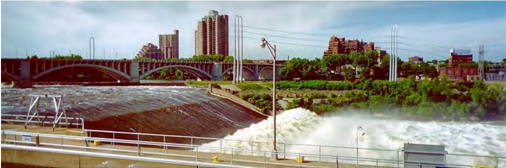
Figure 1.5 – Ressaut hydraulique stationnaire sur le Mississippi au pied du seuil du Saint-Falls Laboratory de Minneapolis (États-Unis). Source : Wikimedia .
