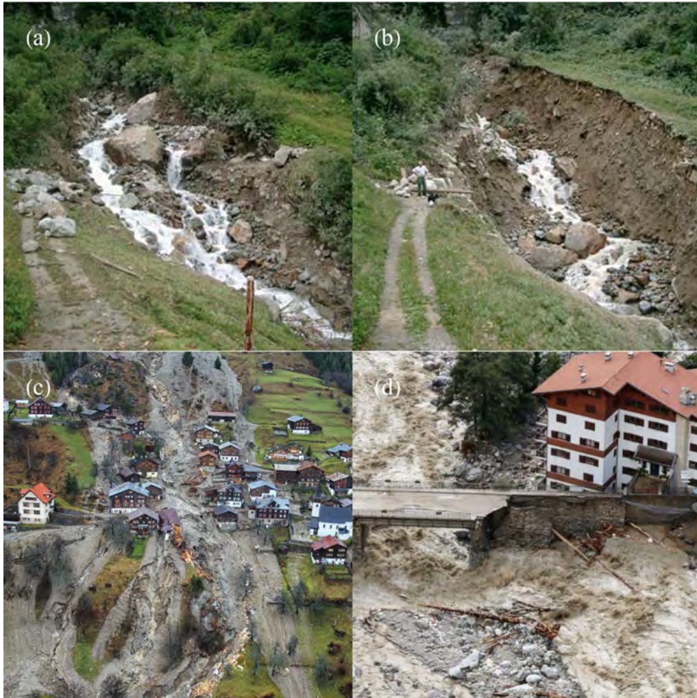
Figure 1.21 – Modification substantielle du lit. (a) et (b) deux vues d'un du Rote Bach (BE) le 28 juillet 2003 et 4 août 2004, après le passage d'une crue qui a emporté une partie des berges. Source: Eva Gertsch ( Gertsch, 2009 ); (c) village de Schlans dans les Grisons après une crue torrentielle en 2002 (source: Planat ); (d) village de Saint-Martin-de-Vésubie (Alpes-Martimes, France) ravagé par la crue de la Vésubie le 2 octobre 2020 (source: La Nouvelle République ).
