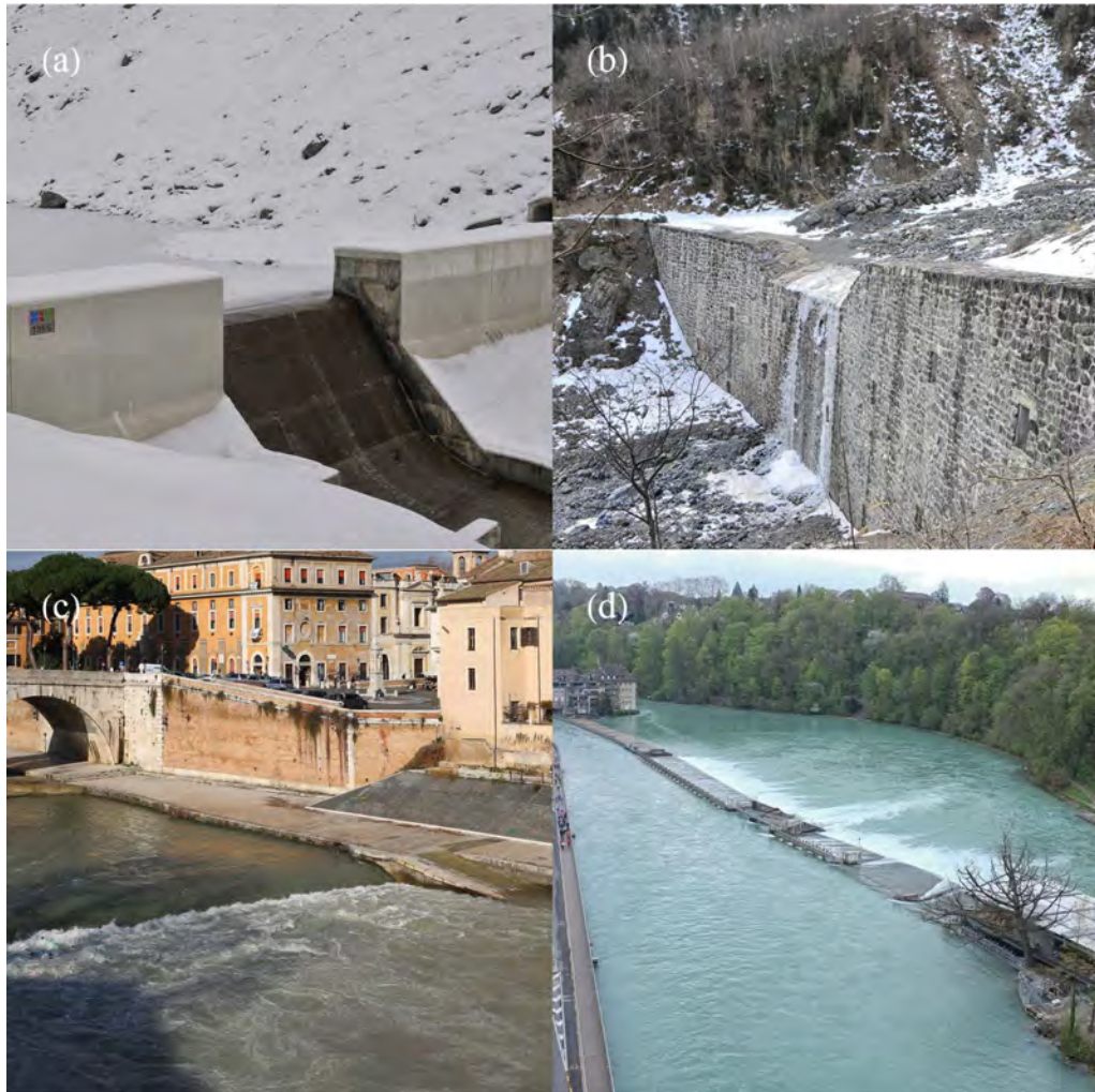
Figure 1.15 – Différents types de seuil et déversoir. (a) Déversoir du lac de Louvie au-dessus de Fionnay (VS); (b) seuil de confortement du lit du torrent de Saint-Barthélemy au-dessus de Mex (VS); seuil noyé sur le Tibre à Rome (Italie); (d) déversoir latéral sur l’Aar à Berne.
