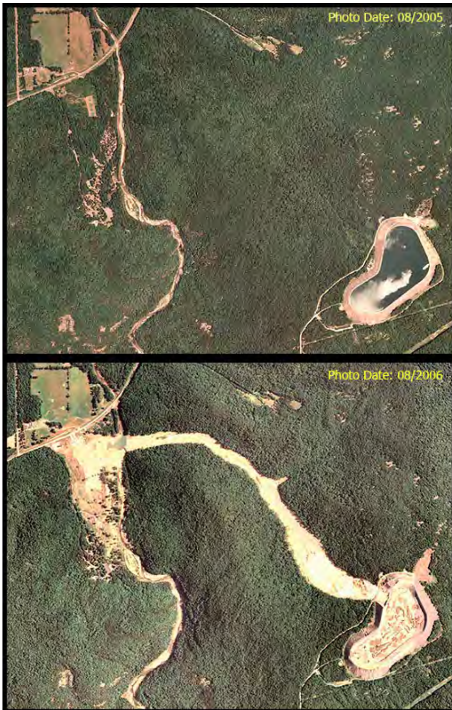
Figure 3.3 – Rupture du barrage de Taum Sauk dans le Missouri (États-Unis) en décembre 2005.
