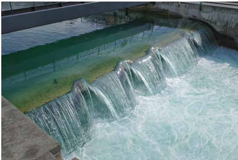
Figure 1.8 – Seuil placé à l'exutoire du lac de Lucerne au débouché de la Reuss.
