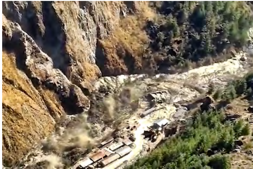
Figure 3.12 – Passage de la débâcle glaciaire au niveau de l’usine hydroélectrique de Tapovan sur la Rishiganga (Chamoli, Inde) le 7 février 2021. Source : Utkarsh Singh (Twitter) sur India Today .
