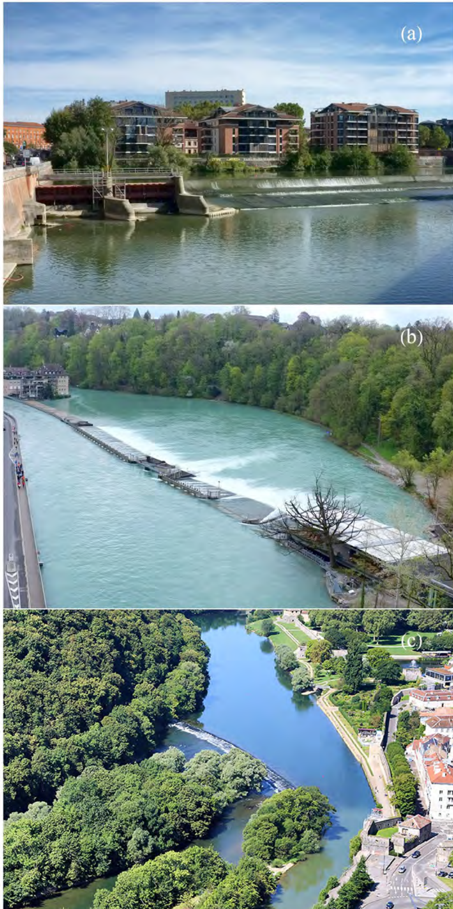
Figure 5.60 – (a) Seuil droit sur la Garonne à Toulouse (France). (b) Déversoir latéral sur l’Aar à Berne. (c) Seuil sur le Doubs à Besançon (France).
