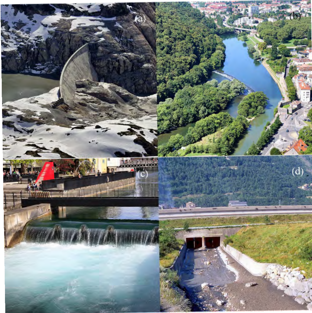
Figure 5.22 – Exemples de singularité hydraulique. (a) Les barrages (ici le Vieux-Émosson au-dessus de Finhaut, VS) barrent le cours des rivières. Ils modifient les débits liquide et solide. (b) Les déversoirs et seuils latéraux (ici le Doubs à Besançon, France) sont des dispositifs permettant d'imposer une certaine cote d'eau et de dériver les eaux vers un canal ou une usine. (c) Les seuils (ici sur la Reuss à Lucerne) sont des ouvrages obstruant le cours de la rivière, ce qui permet de ralentir la vitesse et d'imposer un certain niveau d'eau. (d) Ponts et dalots (ici dalot de l'autoroute A43 en Maurienne enjambant le torrent du Claret) peuvent fortement modifier l'écoulement en limitant sa hauteur et sa largeur.
