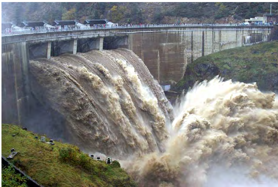
Figure 5.46 – Crue de la Loire de novembre 2008 et passage de la crue au niveau de l'évacuateur de crue du barrage de Grangent. Source : DIREN.
