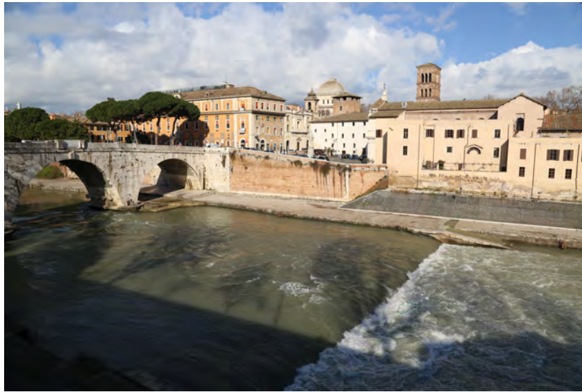
Figure 5.63 – Seuil dénoyé sur le Tibre au niveau de l'île Tibérine à Rome. L'apparition d'eau blanche trahit la formation d'un petit ressaut à l'aval du seuil.
