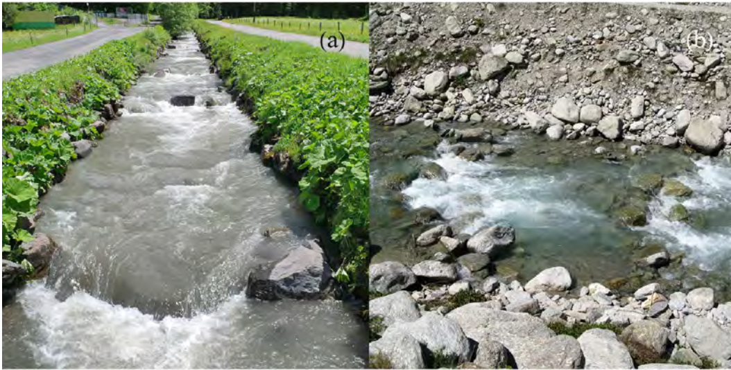
Figure 5.18 – L’alternance de seuils et de mouilles existe même pour les tout petits cours d’eau. (a) Sur la Saufla (val d’Illiez, VS), des seuils artificiels ont été construits pour stabiliser le lit et dissiper l’énergie. (b) Alternance de seuils et mouilles sur un bras de la Navisence à Zinal (VS).
